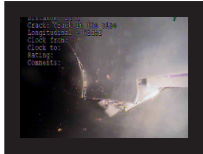
Nứt Vỡ tại Hệ Thống Thoát Nước Thải
