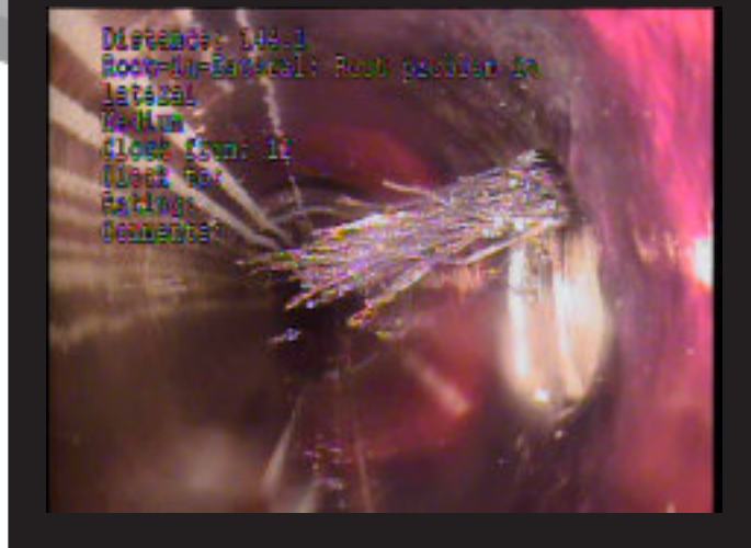
Các rễ mọc trong Hệ Thống Thoát Nước Thải
