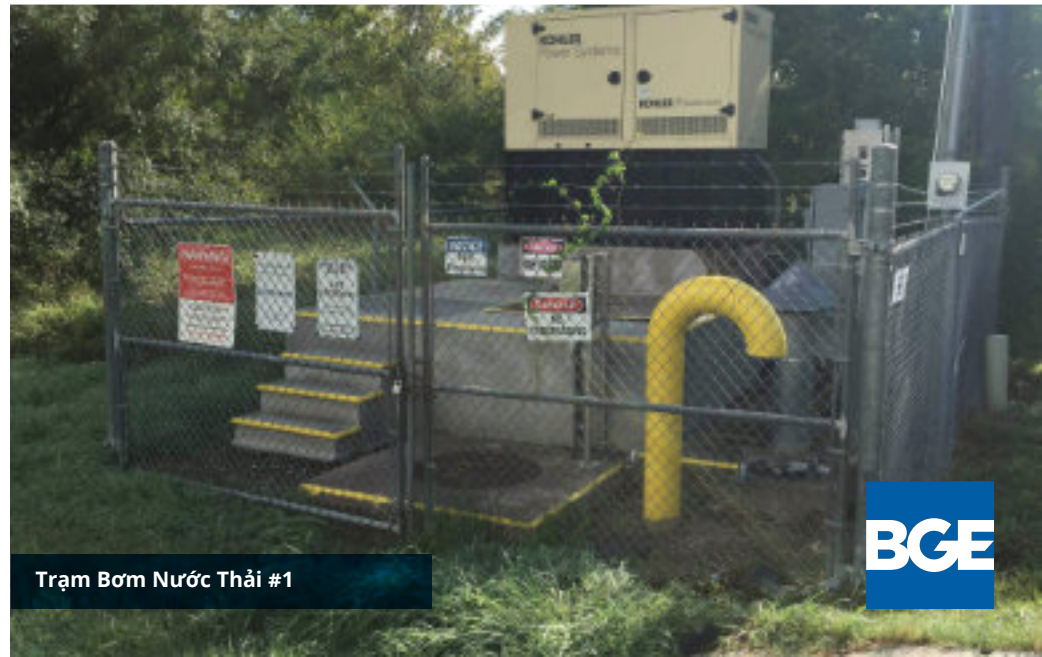
Các Đường Ống Thối Khí của Trạm Xử Lý Nước Thải
